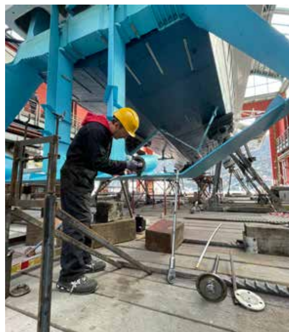
MANUTENZIONE COSTANTE NEI CANTIERI DELL'ENTE
