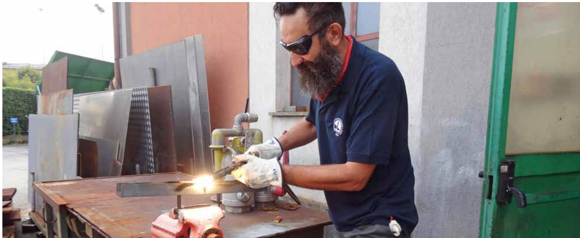
BUSCHINI AL LAVORO PER OPERAZIONI DI SALDATURA
